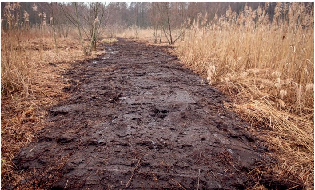
| Mit Minibaggern wurde in der Dahmeniederung ein Graben verschlossen.
