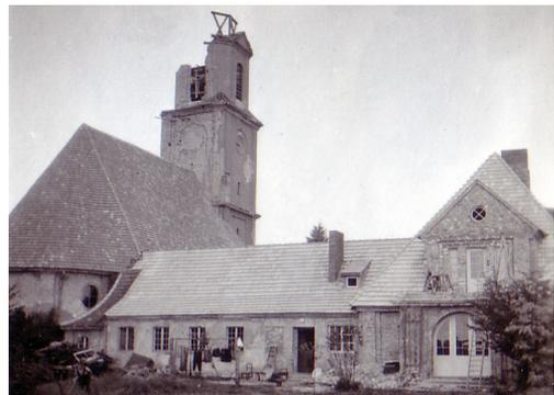
die dritte, oberste Stufe verkürzt rekonstruiert wurde. Weitere Kriegsschäden, z. B. am Dach, wurden unter schwierigen Bedingungen nur notdürftig repariert. Dadurch konnte Hauschwamm stellenweise in das Dachgebälk eindringen. Deshalb ist eine baldige Sanierung dringend notwendig.
